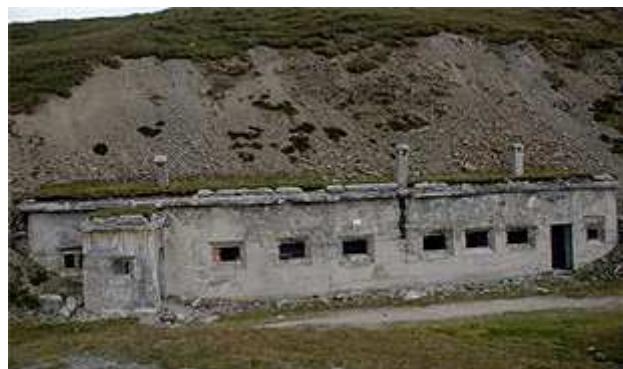
Bunkeranlage aus dem 1. Weltkrieg am Karnischen Höhenweg Foto: Hatz
